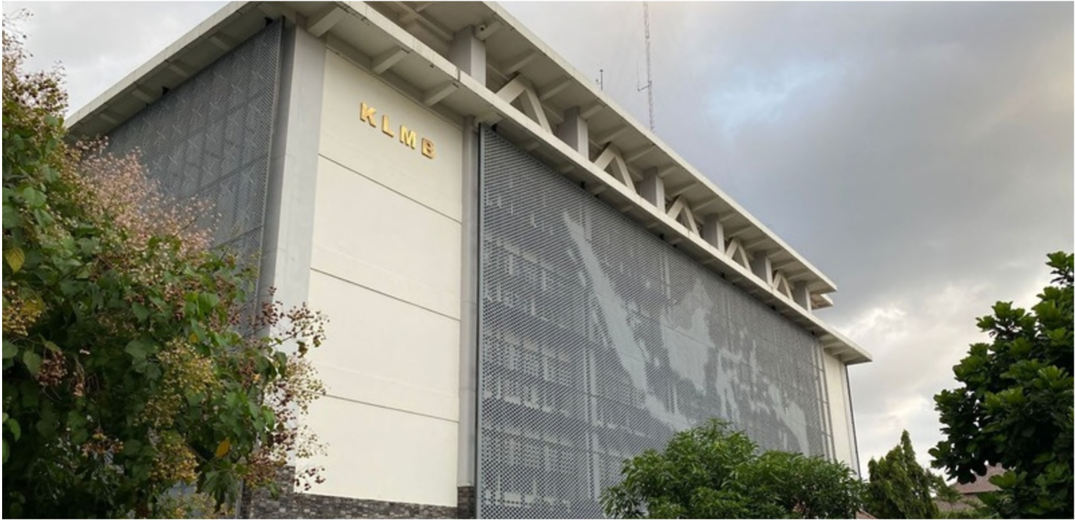
Gedung E: Laboratorium, Kantor Unit Pendukung Fakultas, dan Ruang Kelas
